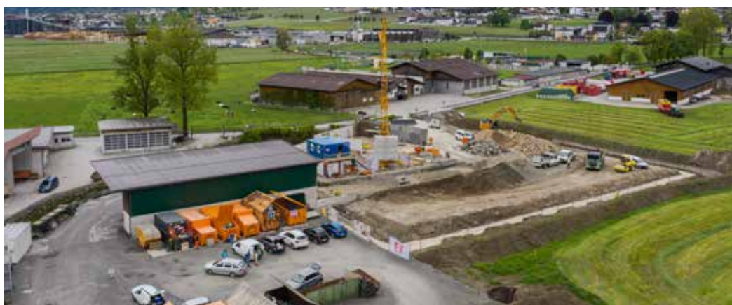
Ansicht von oben: Das neue Abfallwirtschaftszentrum Vorderes Zillertal wächst ...
